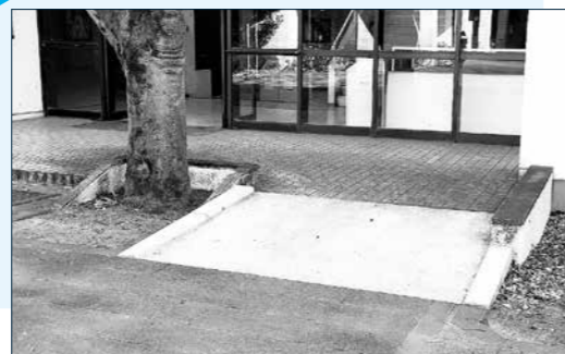
▲〈施設工事例〉建物入口の段差解消
